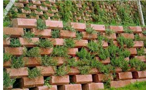
Figura 25 - Barriera antirumore in calcestruzzo ed elementi vegetali
