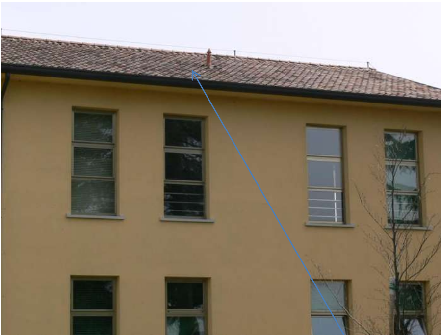
Ulteriore punto in cui si è abbassato prossima al giunto fra corpi di fabbrica
