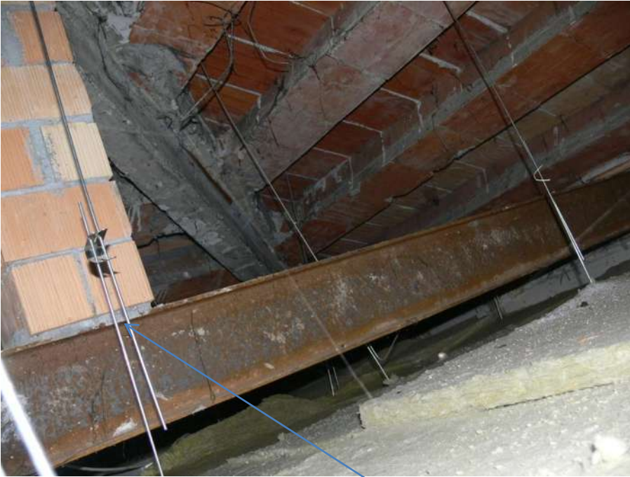
Pilastro di blocchi laterizi appoggiato su putrella in acciaio a sostegno della trave in c.a.
