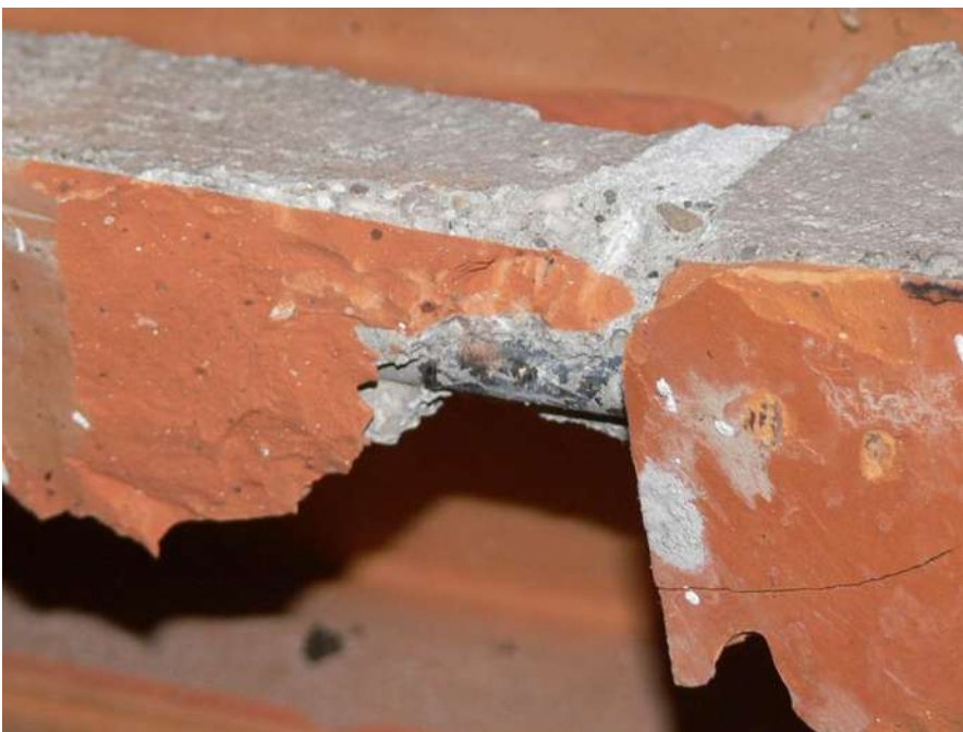
L'unico ferro liscio presente non collegato, nervatura non presente, sconnessione con la cappa in c.a.
