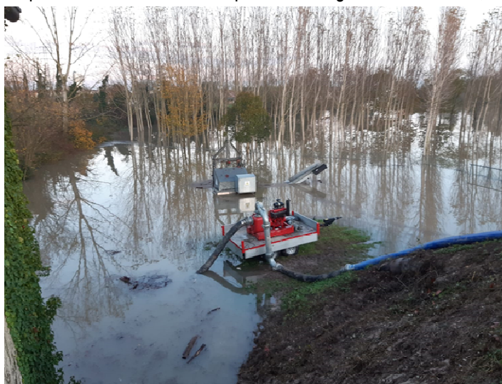
Novembre 2019: installazione pompa di emergenza da parte dei Vigili del Fuoco per scarico verso il fiume Tagliamento
