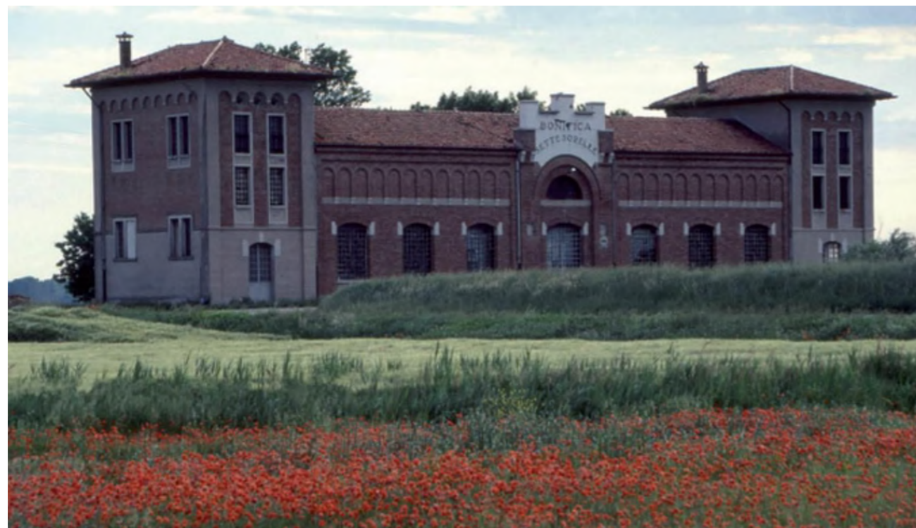
Figura 28 - Impianto idrovoro Sette Sorelle a san Stino di Livenza.
