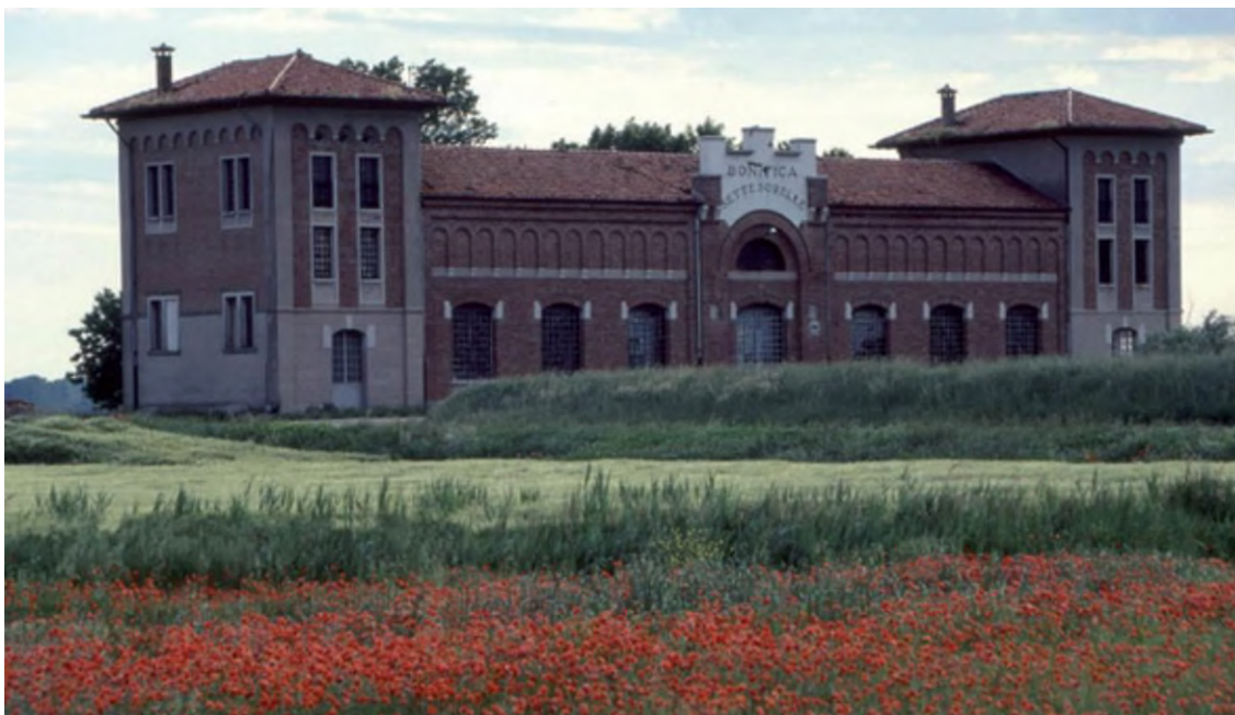
Figura 128 - Impianto idrovoro Sette Sorelle a San Stino di Livenza.
