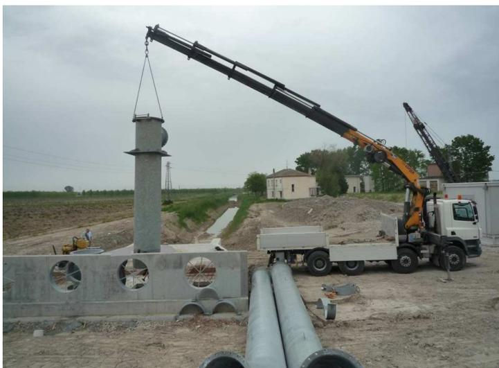
*Fasi di installazione tubo contenitore elettropompa nuovo impianto*
