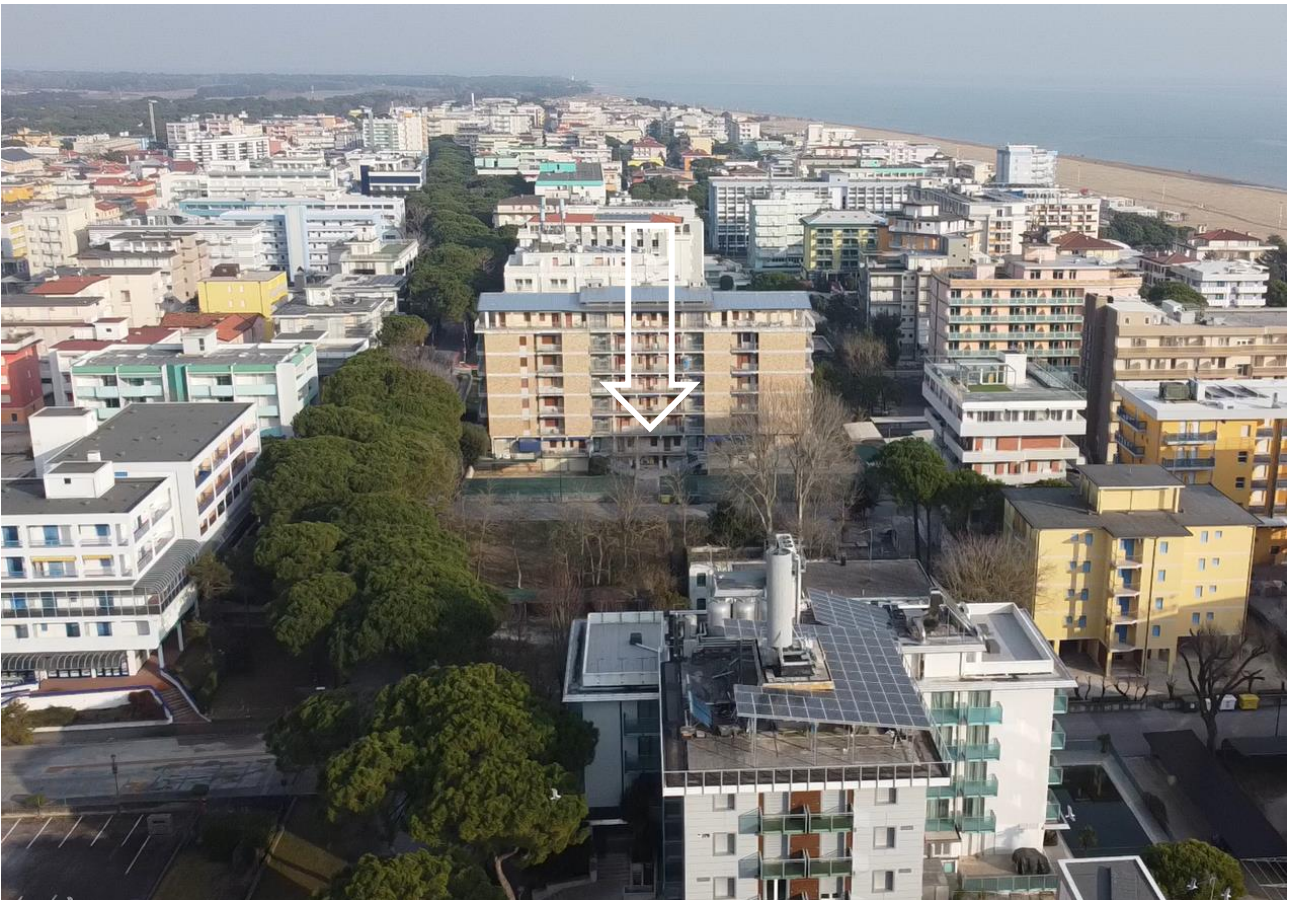
(6) Veduta da ovest verso est
