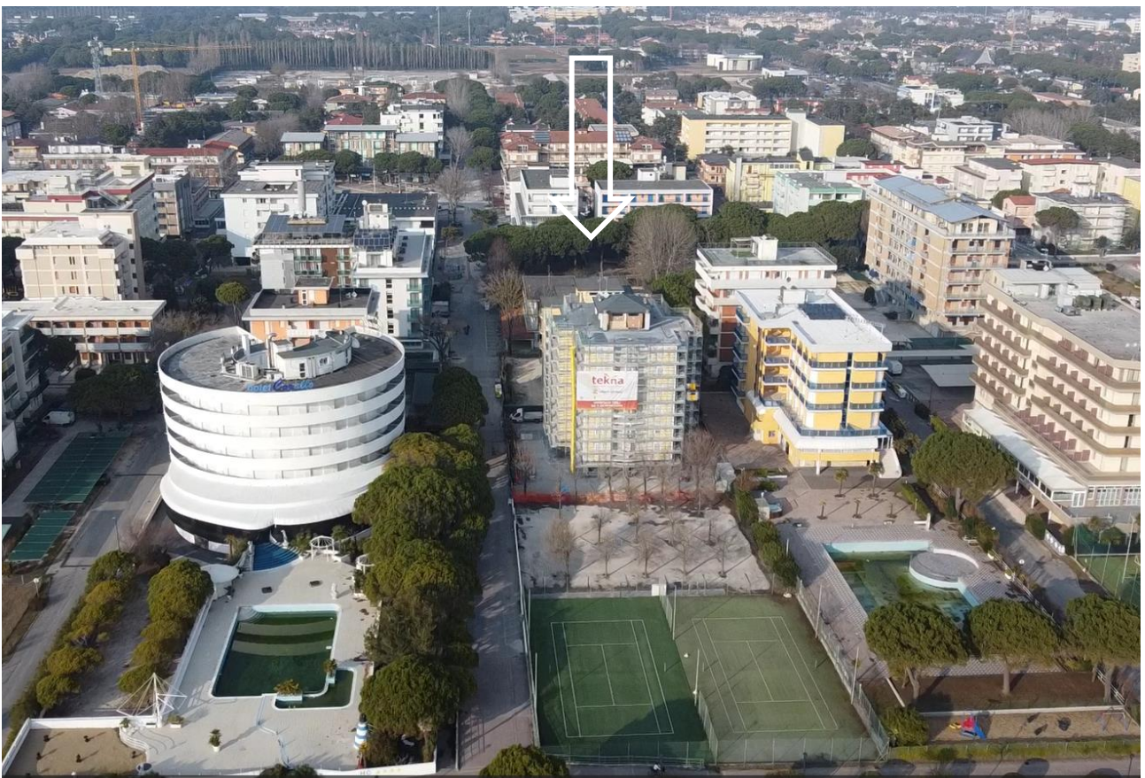
(4) Veduta da sud verso nord
