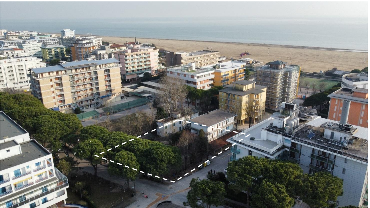
(2) Veduta da nord verso sud
