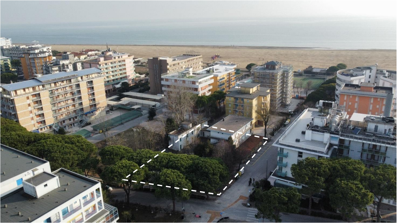
(1) Veduta da nord verso sud
