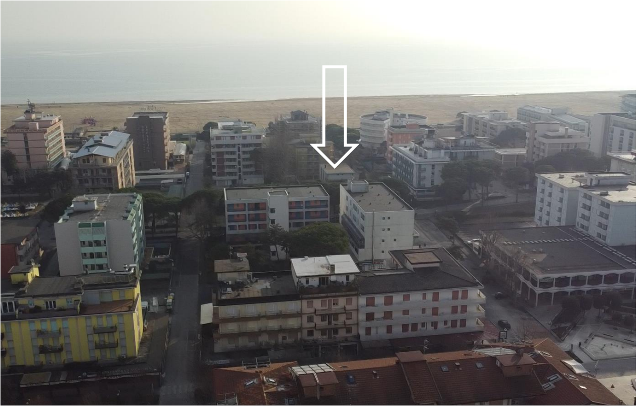
(7) Veduta da nord verso sud
