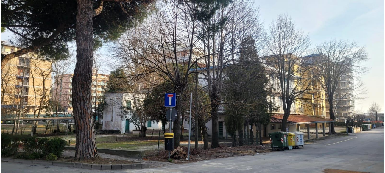
(3) Veduta da nord verso sud
