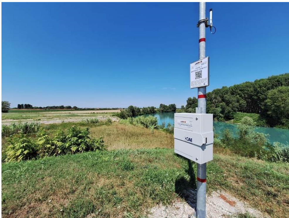
Figura 56. Asta idrometrica DAO provvista di QR-code posta presso l'incile del Canale Cavrato.
