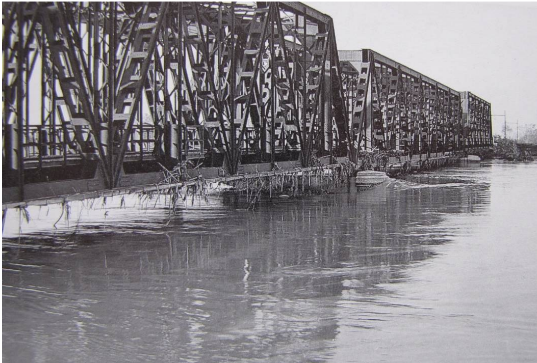
Figura 21: Il ponte ferroviario tra San Michele e Latisana ingombro di ramaglie al decrescere del livello delle acque (Fonte: La Bassa - Associazione culturale per lo studio della friulanità del Latisanese e del Portogruarese).
