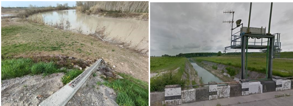
Figura 12: Foto sx: Ansa del Tagliamento e incile del canale Cavrato sullo sfondo. In primo piano l'idrometro Cavrato T.Sl.T.03 - (Distretto Alpi Orientali). Foto dx: attraversamento di via Conciliazione sul canale Cavrato con manufatto di regolazione.
