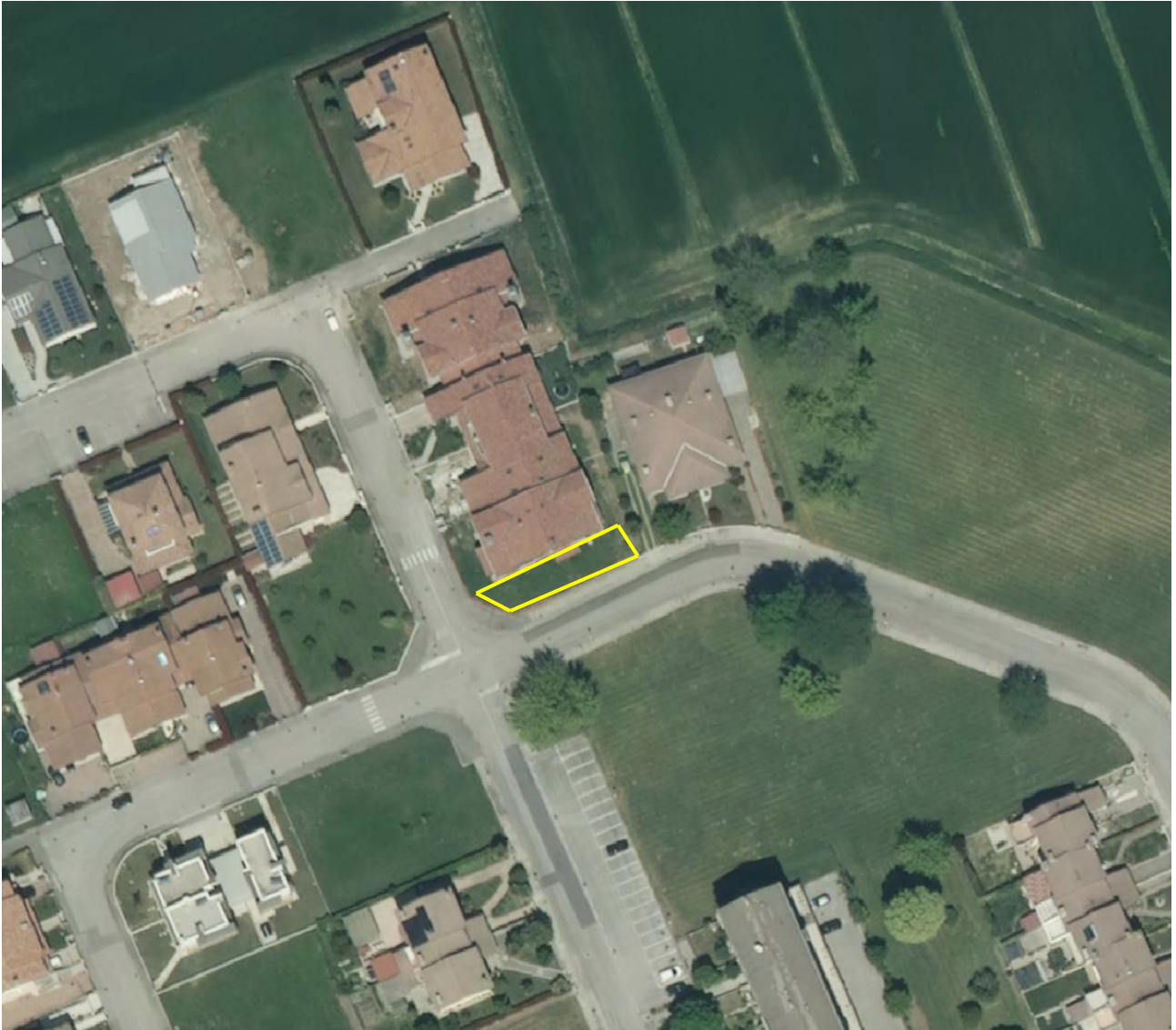
7. AREA PROSPICENTE ABITAZIONE – VIA NELLO E CARLO ROSSELLI, 12 – CAPOLUOGO
