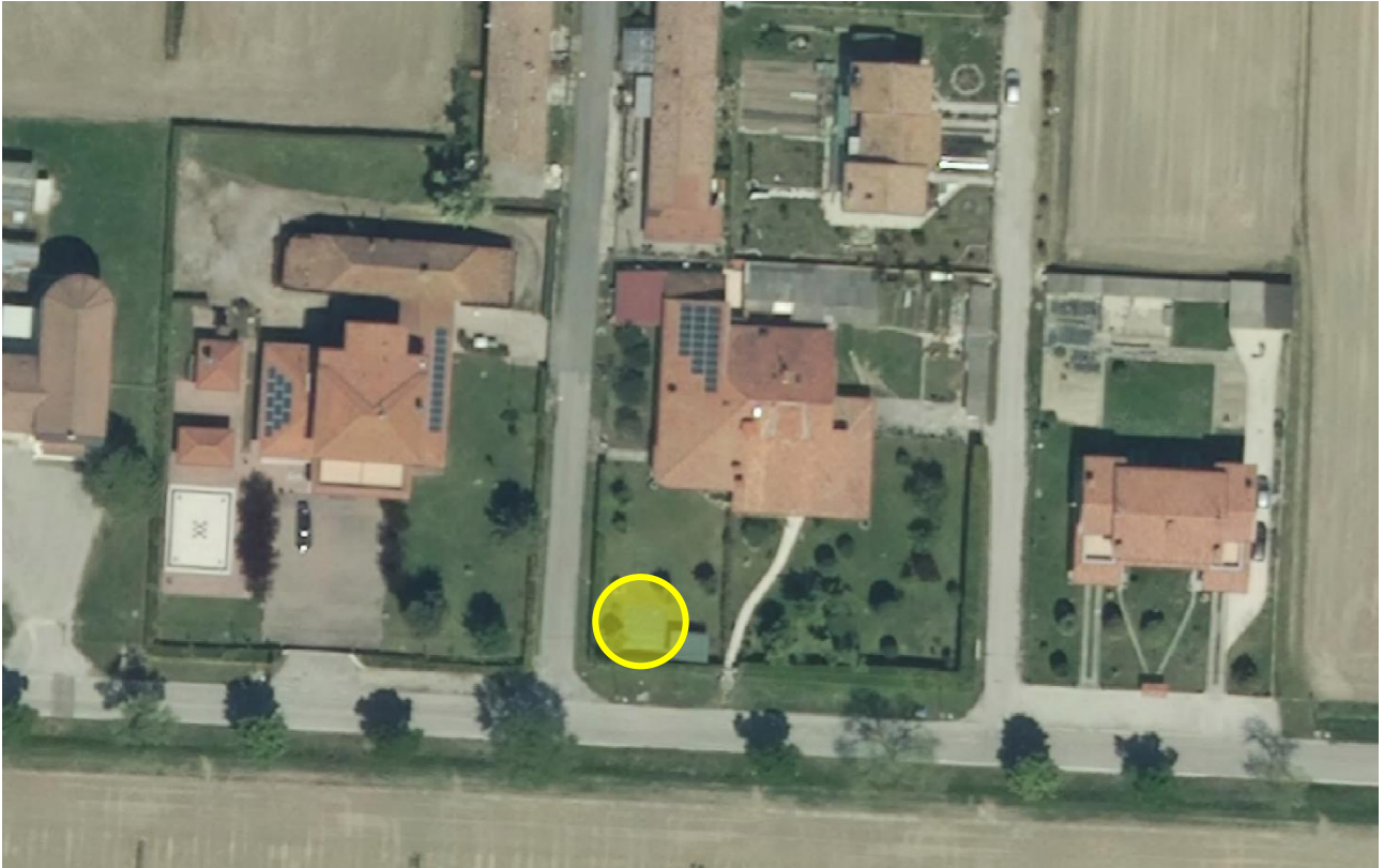
2. EX LOCALE ACQUEDOTTO – VIA VALPELINA, N.15 – LOCALITA' TERZO BACINO
